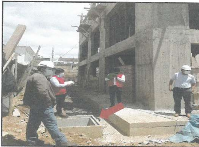
Fuente: Visita a Obra efectuada el 15 de abril de 2021. Elaborado por: Comisión de Visita de Control.
