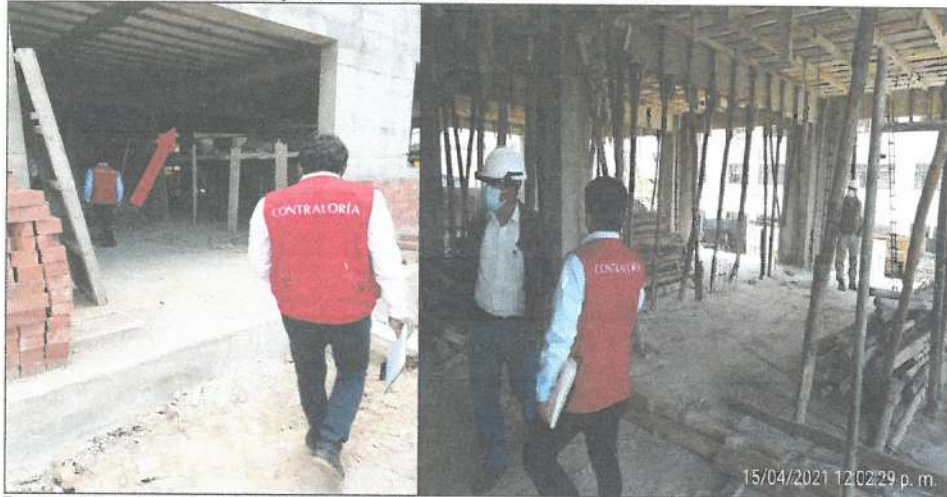
Fuente: Visita a Obra efectuada el 15 de abril de 2021. Elaborado por: Comisión de Visita de Control.
