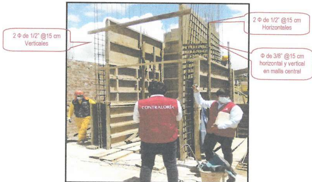
Imagen n.º 5 Colocación de acero en muros armados de caja de ascensor
